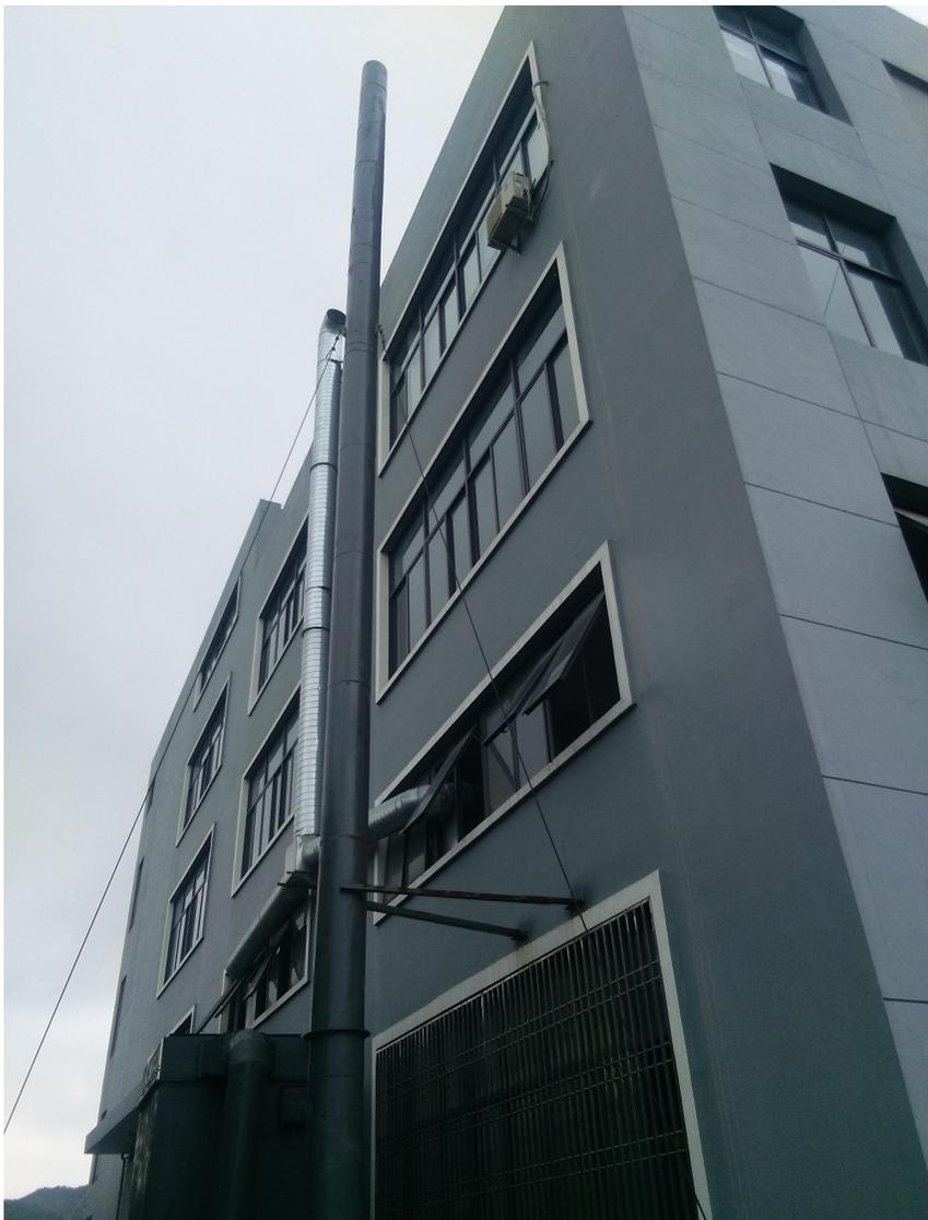
熔化废气排气筒
