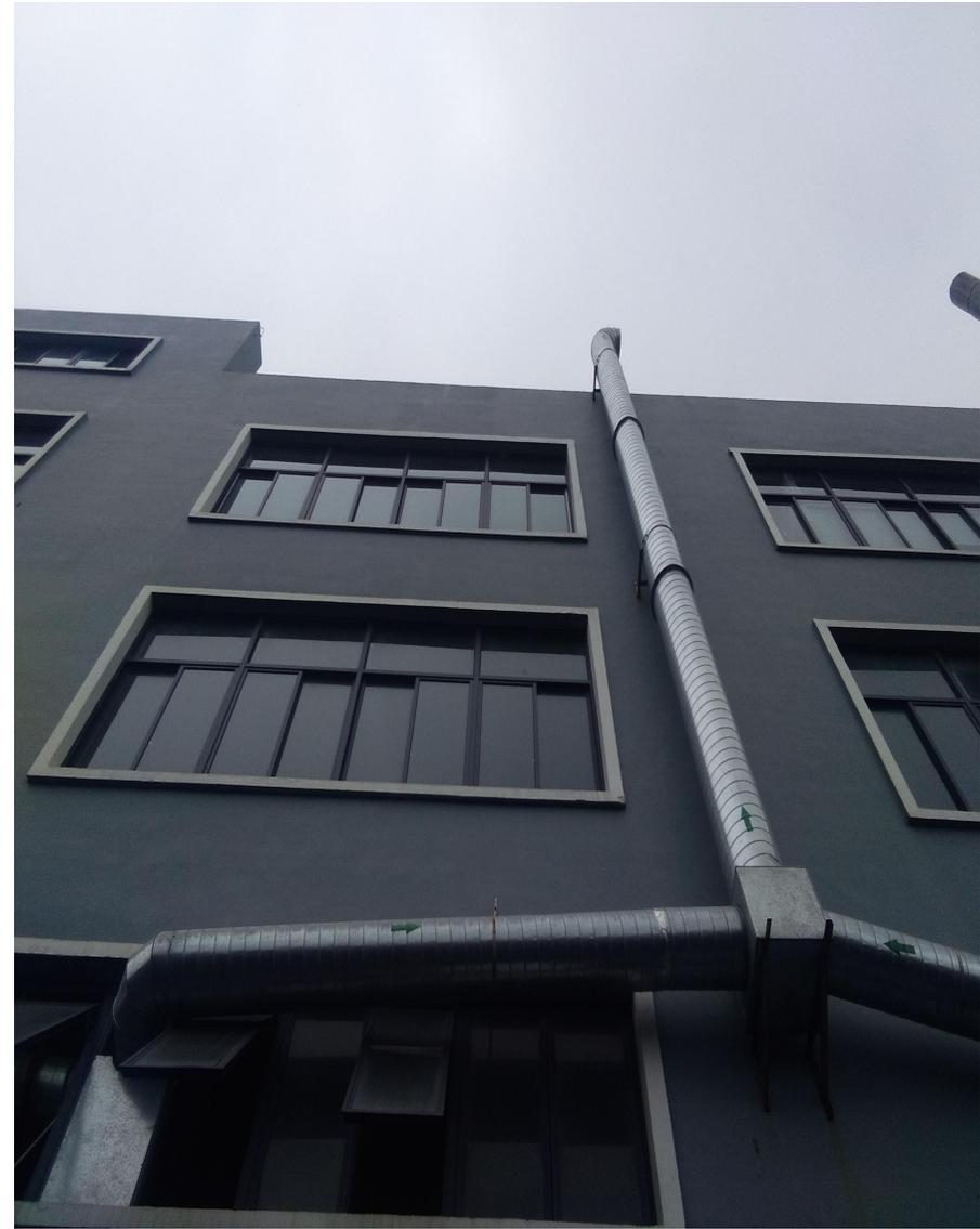
压铸废气排气筒
